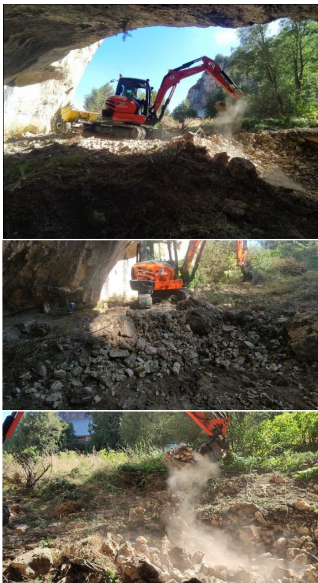
Anexo 13. Limpieza mecánica del nivel coluvial del abrigo de El Estillín.
